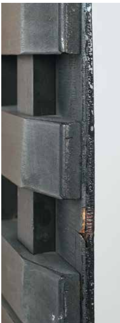
12 Drveni nosilac stanjen u prethodnom zahvatu na debljinu pola centimetra s postavljenom drvenom konstrukcijom na poleđini (foto: V. Benović, fototeka MUO)
